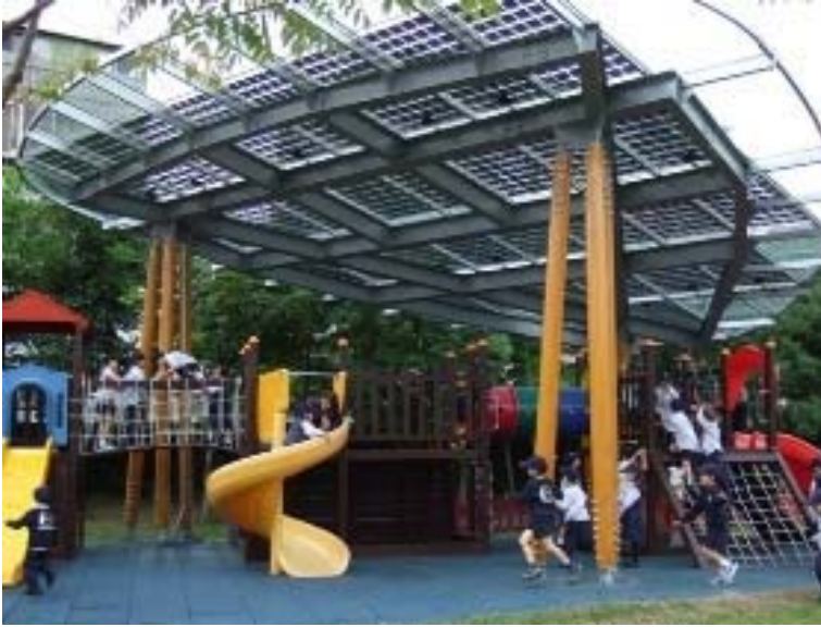
Abbildung 83: Solardach in Teipei (Taiwan)
